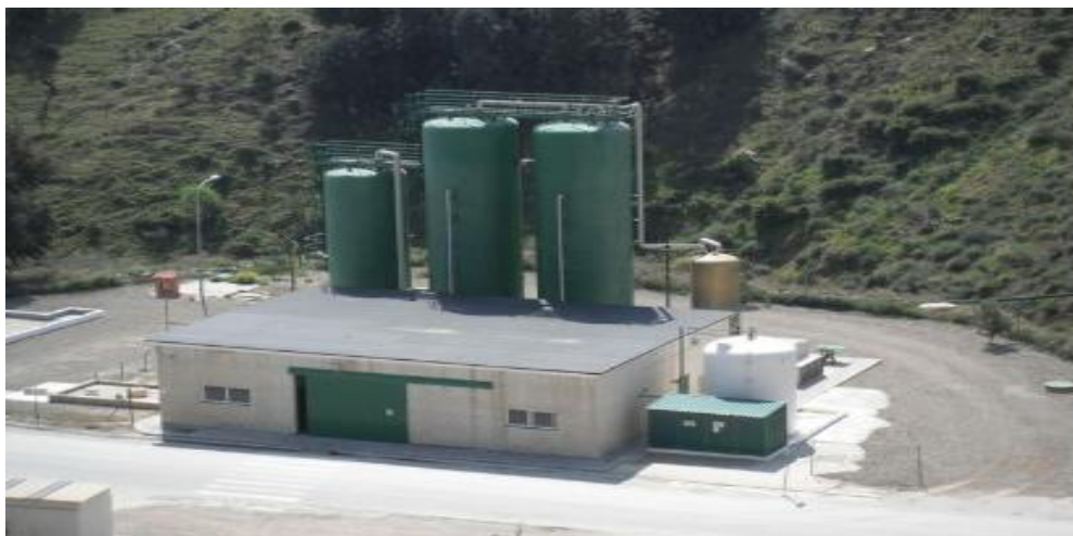
Planta de Tratamiento de Lixiviados
