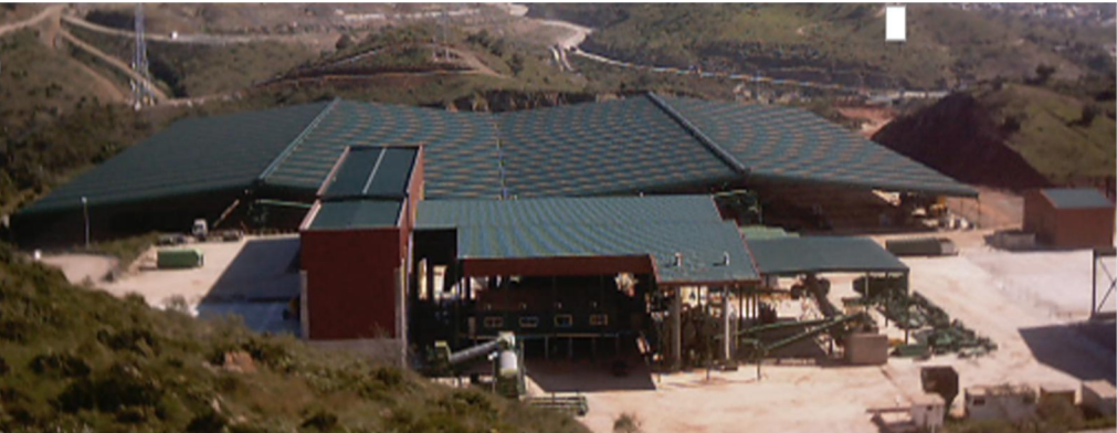
Planta de Tratamiento Mecánico Biológico (TMB)
