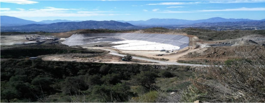
Impermeabilización del Vaso de vertido 2. Año 2015
