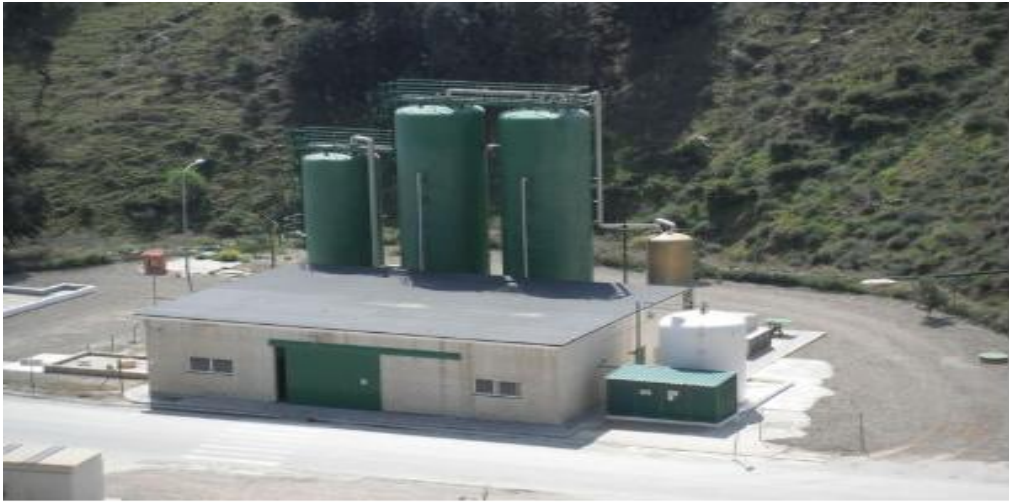
Planta de Tratamiento de Lixiviados
