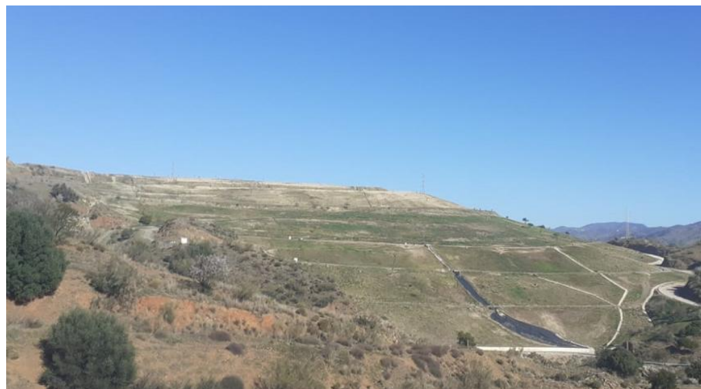
Vista talud Vaso1
